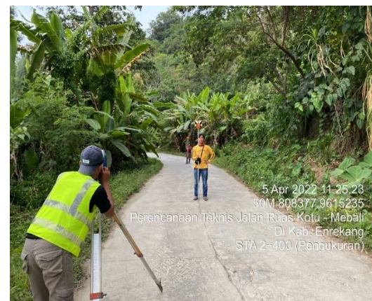
Gambar 3. Proses Pengukuran Jalan
