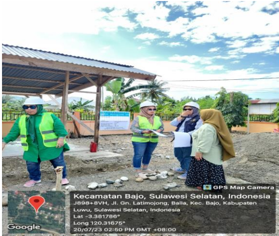
Gambar 2. Peninjauan Lokasi pembangunan Kelas Baru
