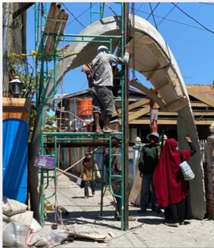
Gambar 2. Pembangunan Pintu Gerbang
